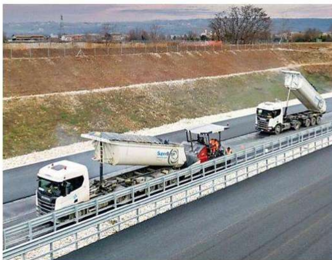
I mezzi di SuperBeton al lavoro lungo la Pedemontana
