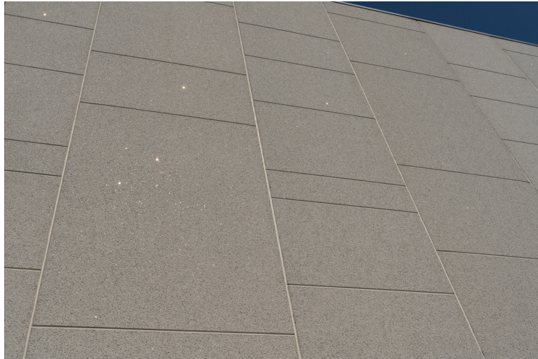
Magnetti Building | L'effetto ottenuto dall'esposizione del rivestimento alla luce del sole è brillante, pulito e semplice.
