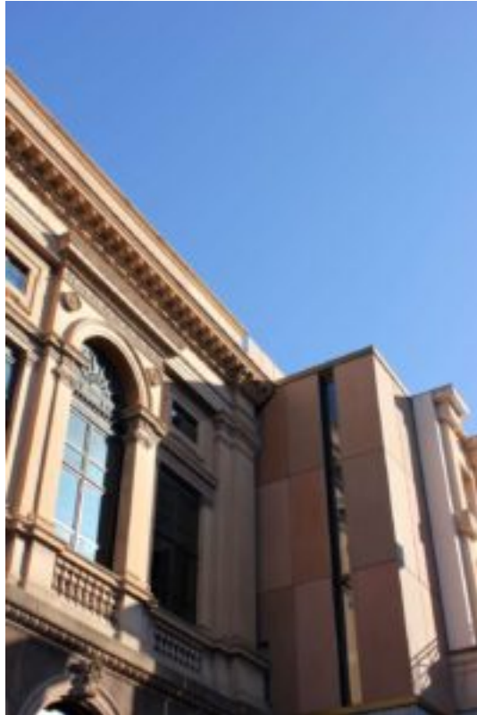
Magnetti Building | I pannelli prefabbricati in calcestruzzo rivestono le facciate laterali e la torre scenica del teatro.
