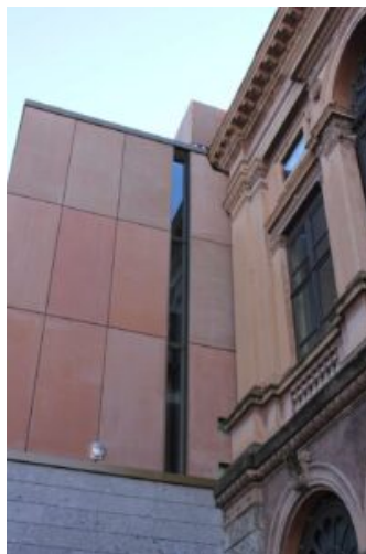
Magnetti Building | I pannelli prefabbricati in calcestruzzo rivestono le facciate laterali e la torre scenica del teatro.
