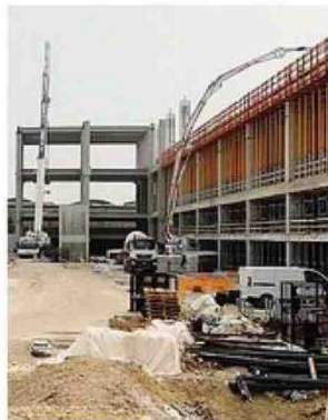
Cascina Merlata: lavori Magnetti
