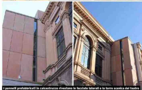
I pannelli prefabbricati in calcestruzzo rivestono le facciate laterali e la torre scenica del teatro
