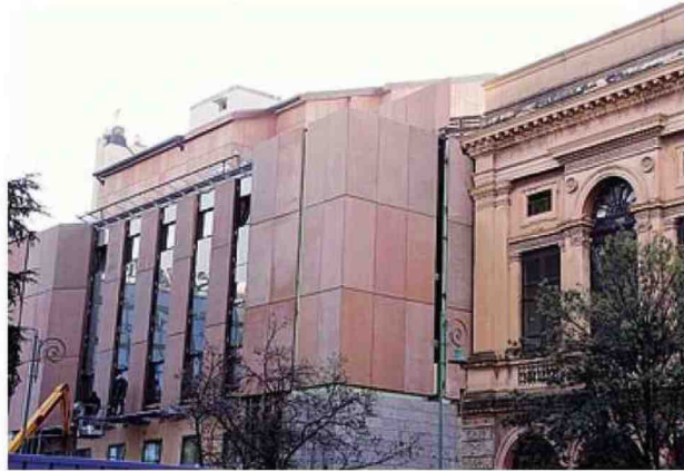
I pannelli in cemento che rivestono le facciate del teatro FOTO BEDOLIS
