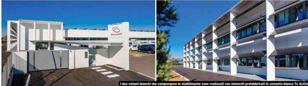
I due volumi bianchi che compongono lo stabilimento sono realizzati con elementi prefabbricati in cemento bianco Tx Active
